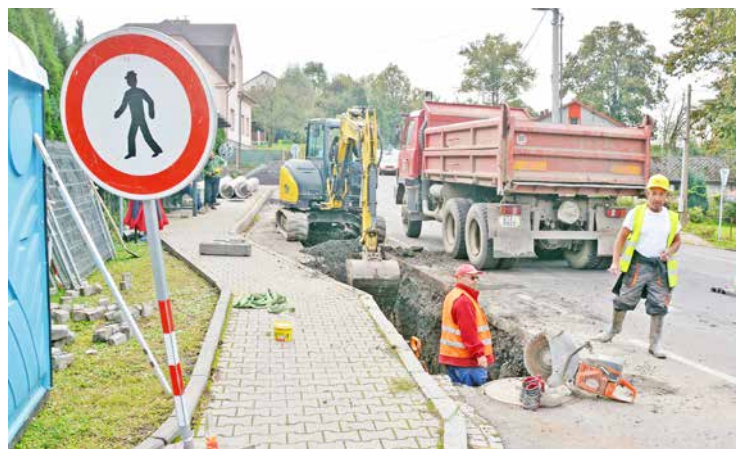
Vybudování přechodu u Partyzána předcházela výměna kanalizačního potrubí.
