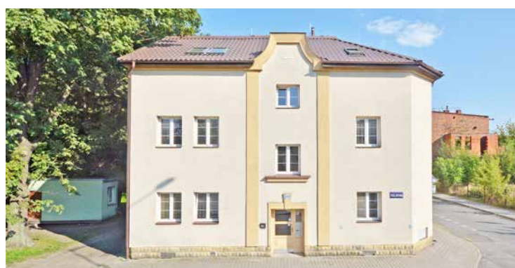
V opraveném cihlovém domě v ulici Čáslavské 268 se 10. listopadu licituje jednopokojový byt. Zájemci si jej mohou prohlédnout 8. a 9. listopadu.
