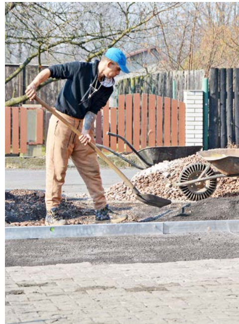
Při rekonstrukci zpevněných ploch na záblatském hřbitově posloužila rozebraná dlažba z přednádražního prostoru.
