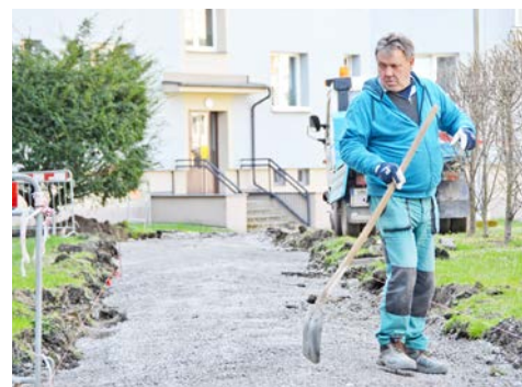
Údržba městských komunikací odstartovala opravou chodníku a parkovacích ploch ve dvoře s vjezdem z Čáslavské ulice.
