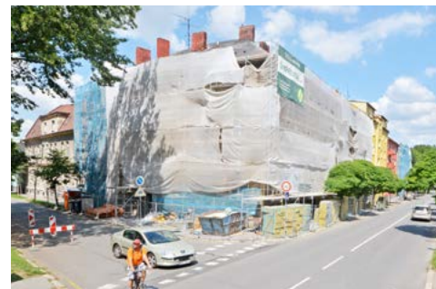
Rovnou čtyři městské nemovitosti prochází rekonstrukcí v okolí křižovatky u evangelického kostela.
