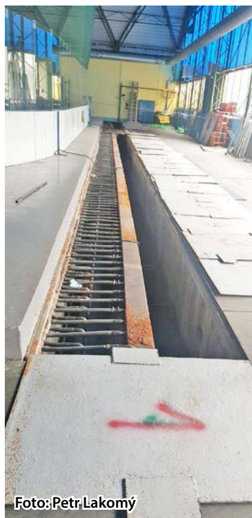
Původní kovové rozvody solanky a moderní plastové.
