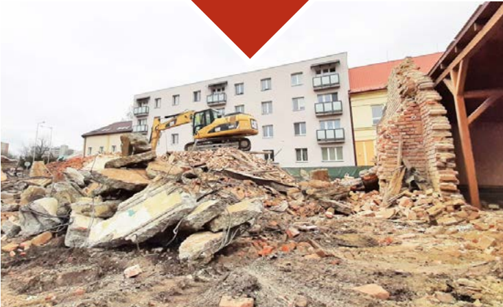
Snímek nahoře zachycuje podobu domu před demolicí, fotografie dole pak stav po zahájení bouracích prací. Foto: Lukáš Kania
