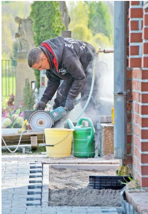
Výstavba okapového chodníku a vsakovací jámy ve Skřečoni.
