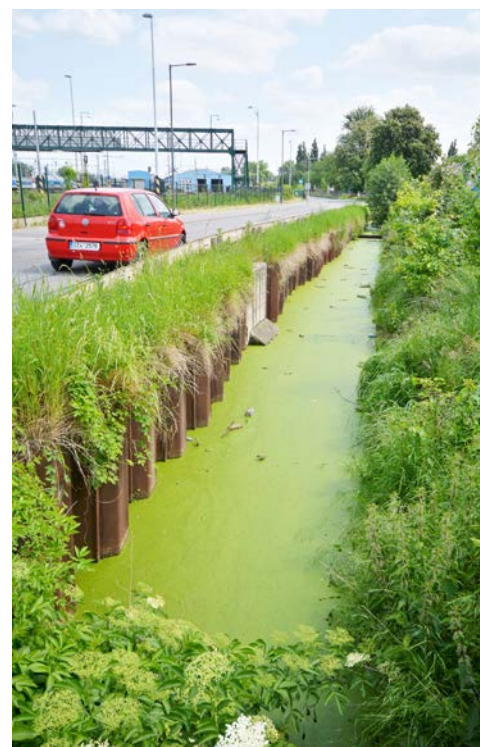
Rekonstrukce čeká i opěrné zdi podél potoka, který se na konci ulice vlévá do Bajčůvky.
