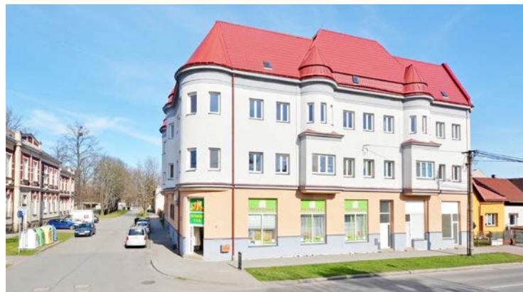
Ve zrekonstruovaném nízkopodlažním domě v Bezručově 542 je k dispozici byt 3+1. Zájemci si jej mohou prohlédnout 5. června a ve stejný den se koná i opakovaná licitace.
