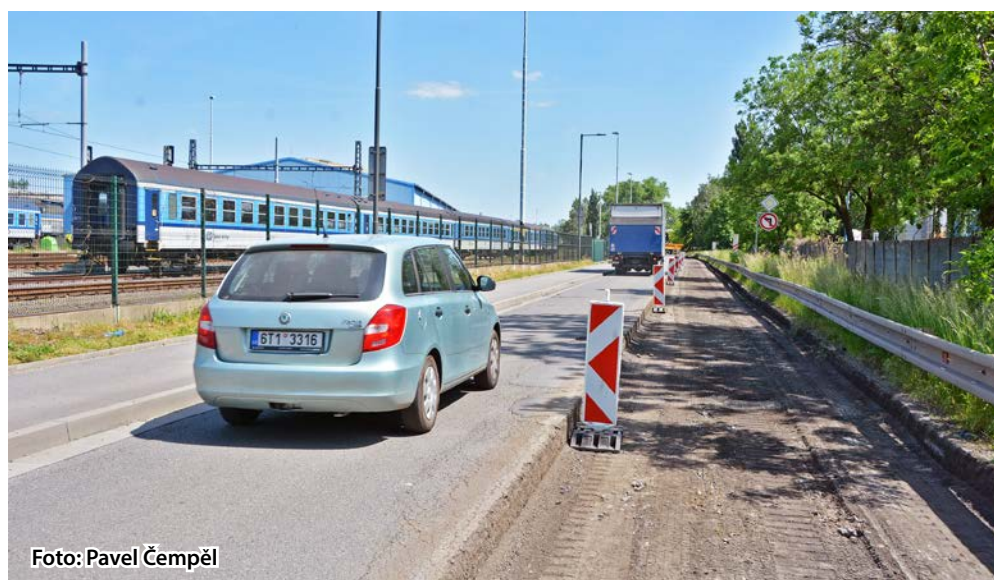
V hlubokých výmolech si nejezdí řidič přivodil defekt či jiné poškození.
