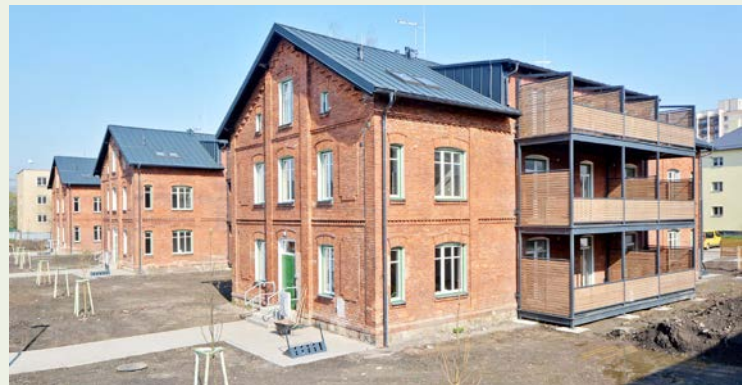
V plném proudu už jsou licitace bytů v kompletně zrekonstruovaných osmi domech v Červené kolonii.
