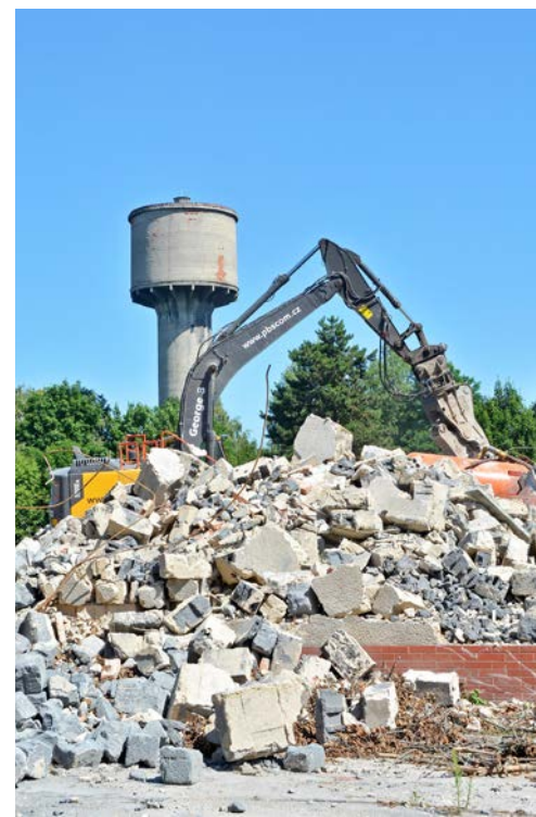
Demolice historické kotelný, na jejímž místě má vyrůst léčebna dlouhodobě nemocných.
