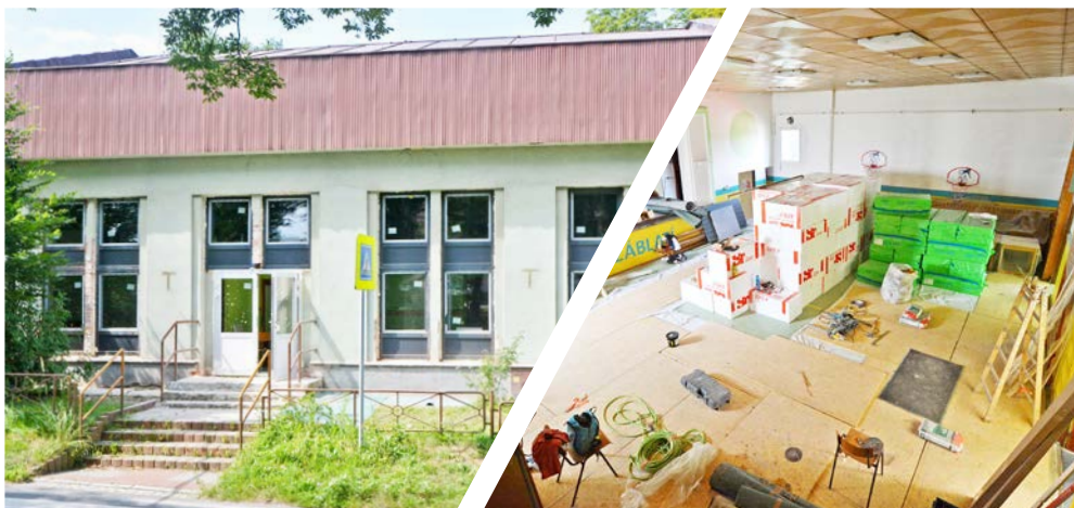
Tělocvična záblatské malotřídky dostává nová okna, dveře i fasádu.
