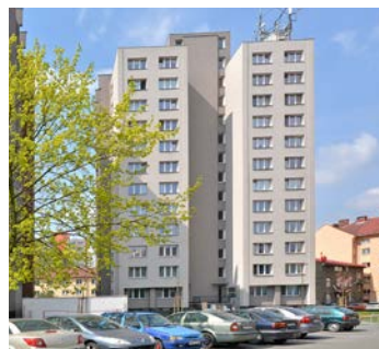
V zatepleném věžáku v Alešově ulici 1070 je k dispozici jednopokojový byt, který se bude 30. října opakovaně licitovat. Jeho prohlídka se uskuteční 25. října.
