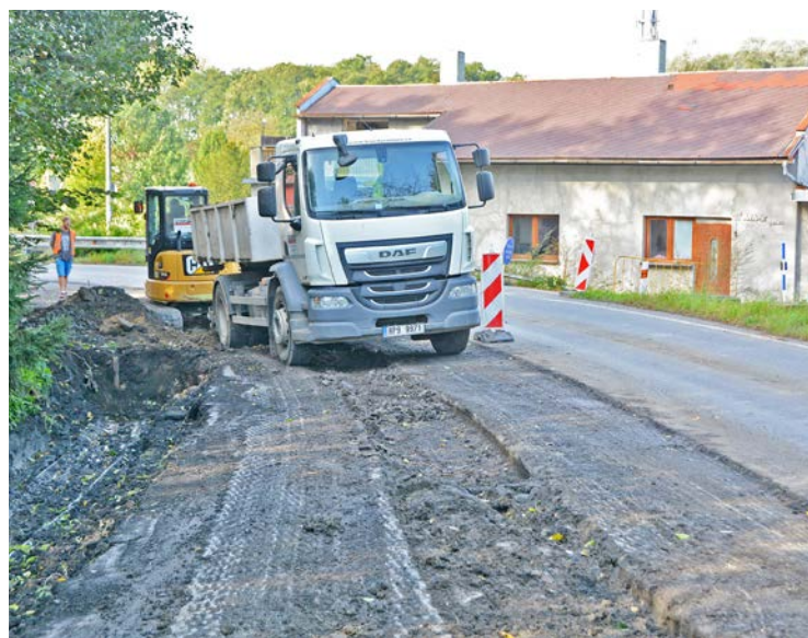
Předělem etap je zatáčka pod bývalou polskou školou. Po dokončení obou vznikne kanalizace pro čtyřiapadesát domů a 650 metrů chodníku.
