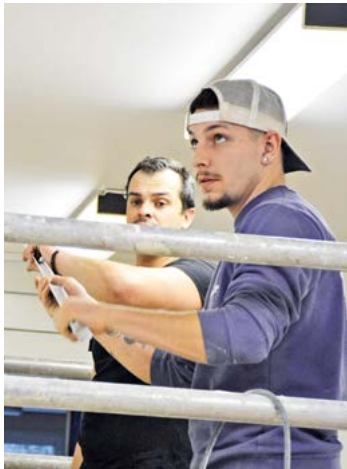
Prosincové snižování stropů a výměna svítidel na poliklinice.
