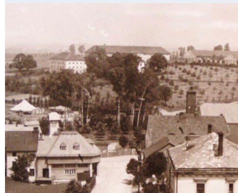
Historická fotografie Dolní Lutyně, na které je ještě vidět renesanční část zámku, která byla v roce 1985 zbořena.
