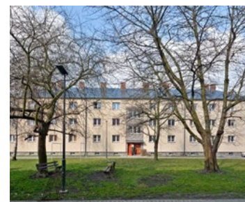
V nízkopodlažním domě v Jateční 152 se uvolnil byt 1+1. Zájemci si ho mohou prohlédnout 10. a 11. prosince, licitovat se bude 16. prosince.
