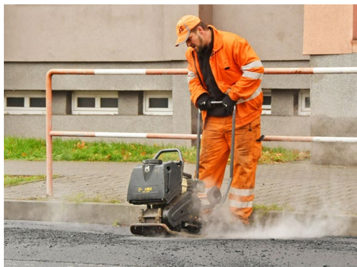
Po frézování a přípravě povrchu se cestáři 15. listopadu pustili do asfaltování Štefánikovy ulice.
