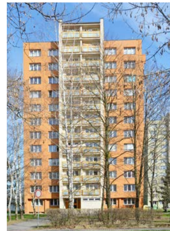
Ve věžovém domě v Bezručově 1143 se uvolnil byt 3+1. Zájemci si jej mohou prohlédnout 9. a 10. června, licitovat se bude 16. června.
